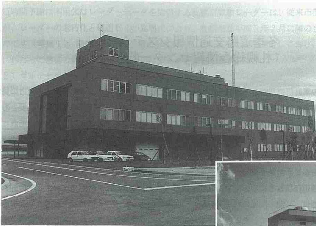
新千歳航空測候所庁舎3Fに入居、屋上は観測棟
