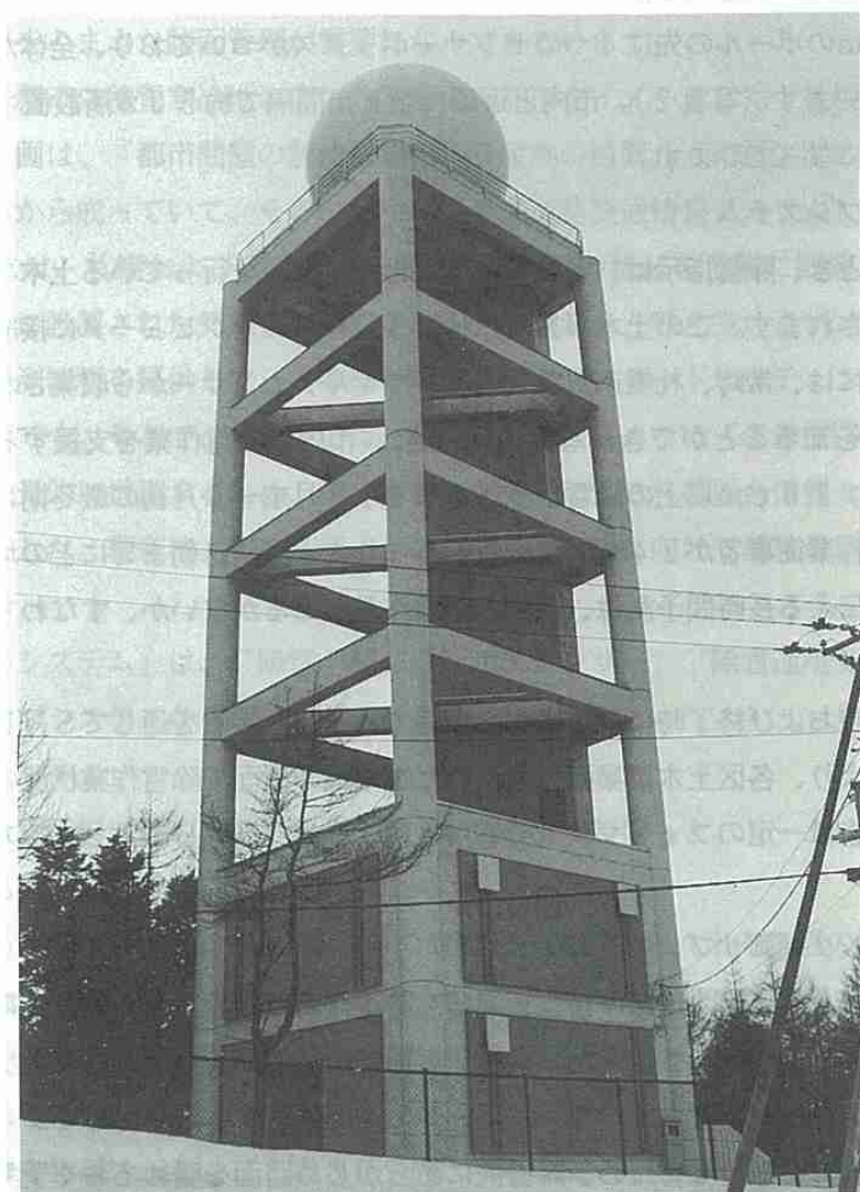
写真1 札幌市気象レーダー
