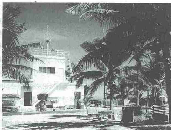
写真3 気象観測所庁舎。屋上に測風塔、日射計がある。
