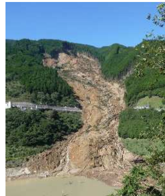
平成 23 年台風第 12 号による土砂災害（奈良県）
