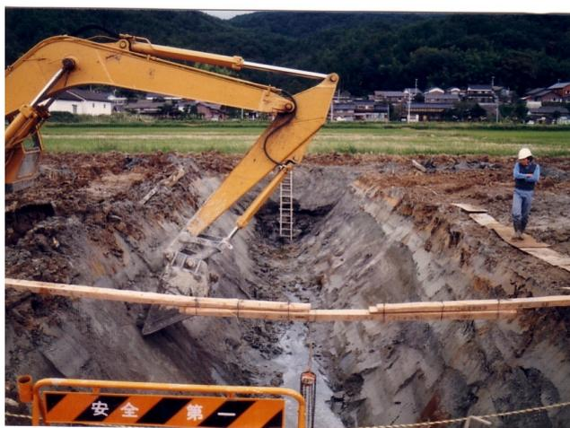
図5．活断層の発掘調査の様子。断層を横切る大きな溝（トレンチ）を掘削し、斜面に現れる断層のずれを調べ、何回、いつ頃、どのくらい変位したかを調査し、断層の活動度を評価するために行われている。
