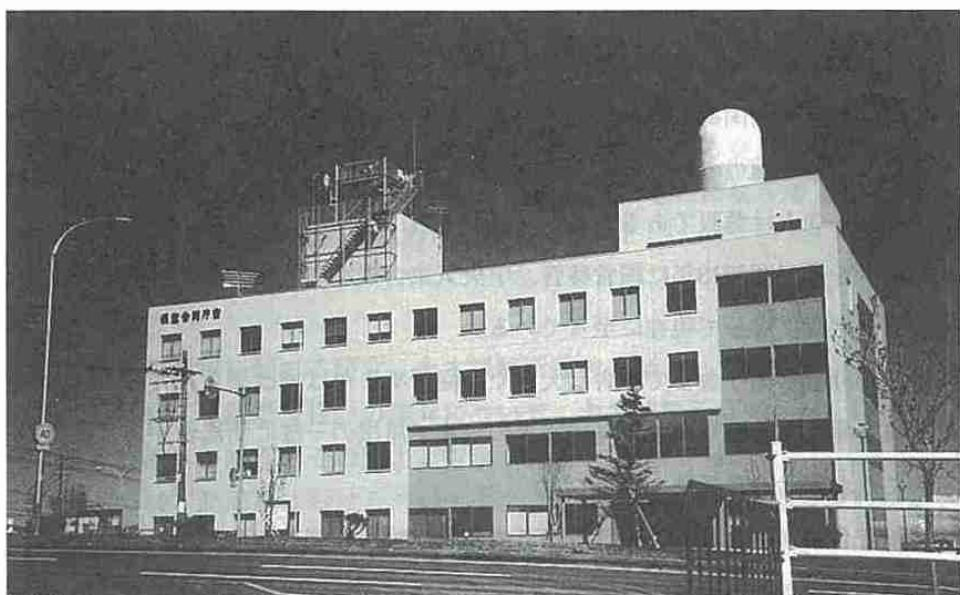
この庁舎の建設にあたり露場は北に約50m移動したが高さはほとんど変わっていない。しかし風速計の高さは大きく変わって旧庁舎時代の11.7mから工事の都合で一時仮設のパンザマストに移された後、最終的に93年8月26日新庁舎の測風塔に移され地上高29.1mになった。これにより風の統計が切断されているので
